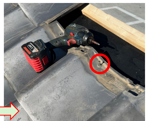
② 進入部分の瓦を離脱 ※ビス又は釘を1枚ずつ抜く必要がある。
