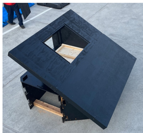
③ 屋根部材を設置
