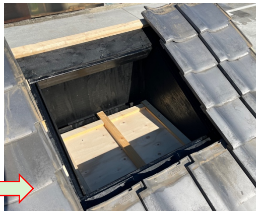
④ 栈木、屋根板、垂木、ルーフィングペーパーを破壊して開口
